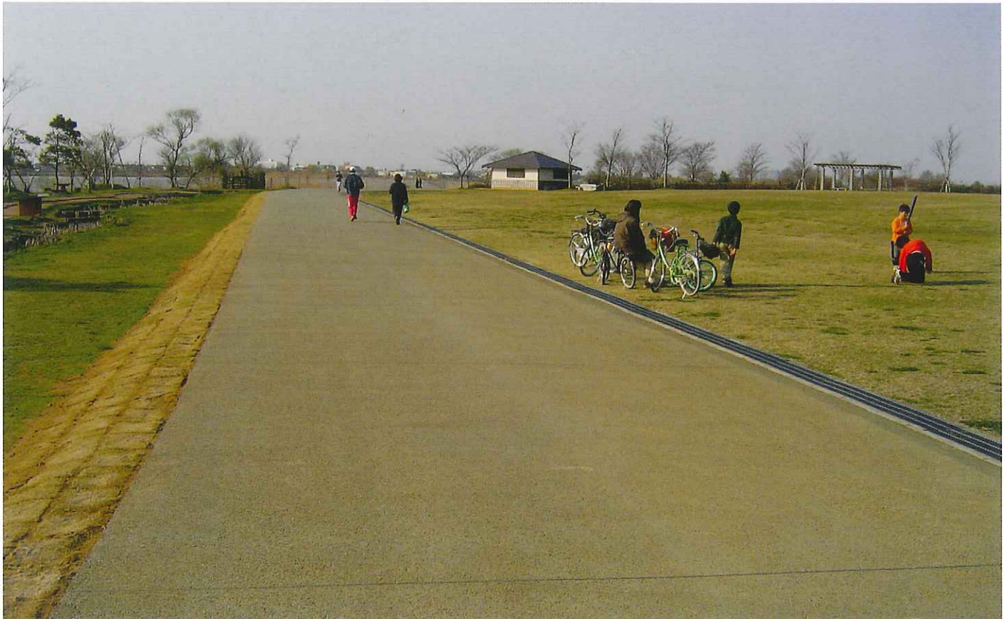
K-グラウンド (C) セメント固化 (透水性&amp;保水性舗装)
