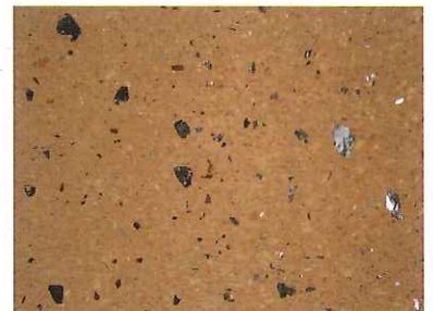
K-グラウンド (CO) 瓦コンクリート 保水性舗装表面
